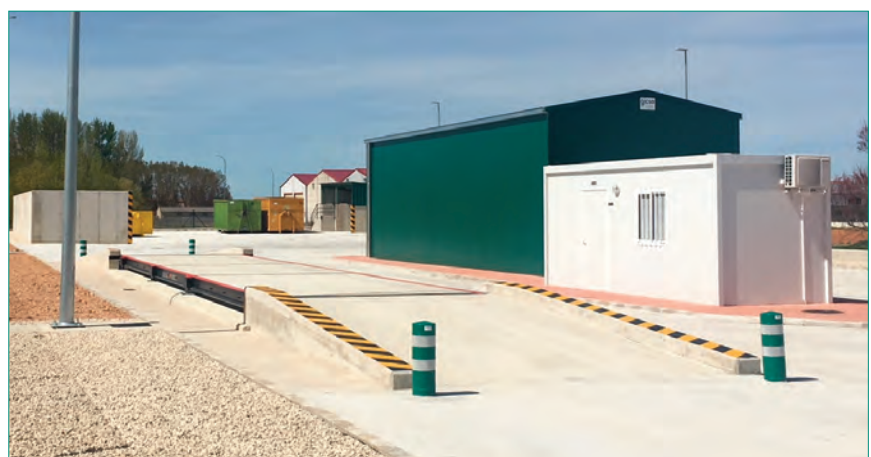
La planta de transferencia y pretratamiento de RCDs de Villadiego fue inaugurada el pasado mes de febrero
