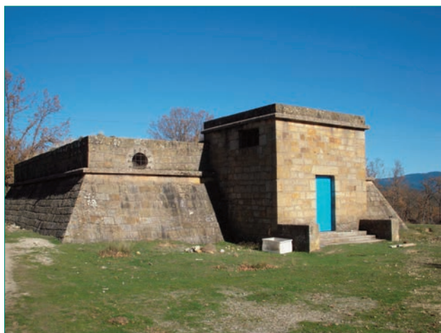
La instalación de cloradores automáticos en los depósitos de distribución ha sido uno de los proyectos más demandados
